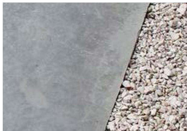
Betonpad met halfverharding erlangs
