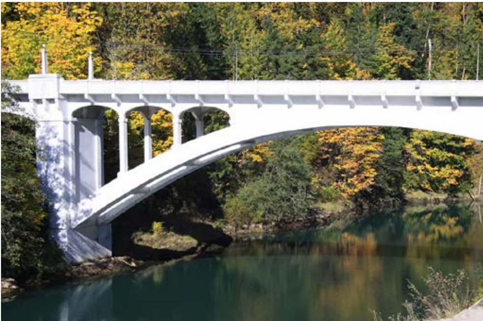
Een viaduct bij de B.M. Teldersweg verbindt de parken fysiek aan elkaar.
